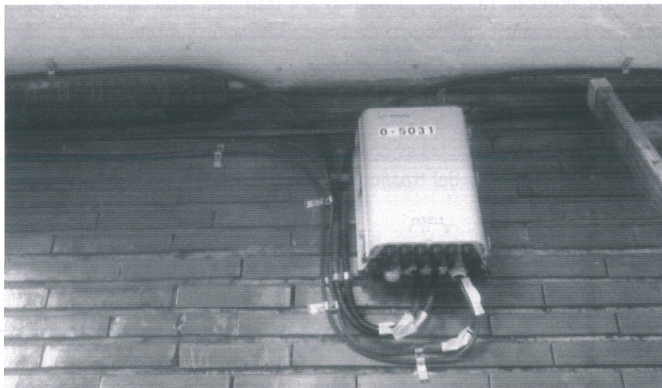
Ilustración 18. Detalle Caja terminal óptica (CTO) exterior.
