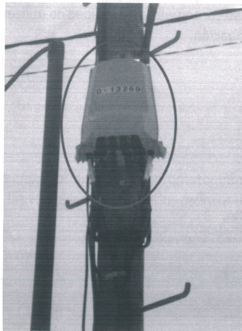
Ilustración 21. Caja terminal óptica (CTO) instalada en Poste.
